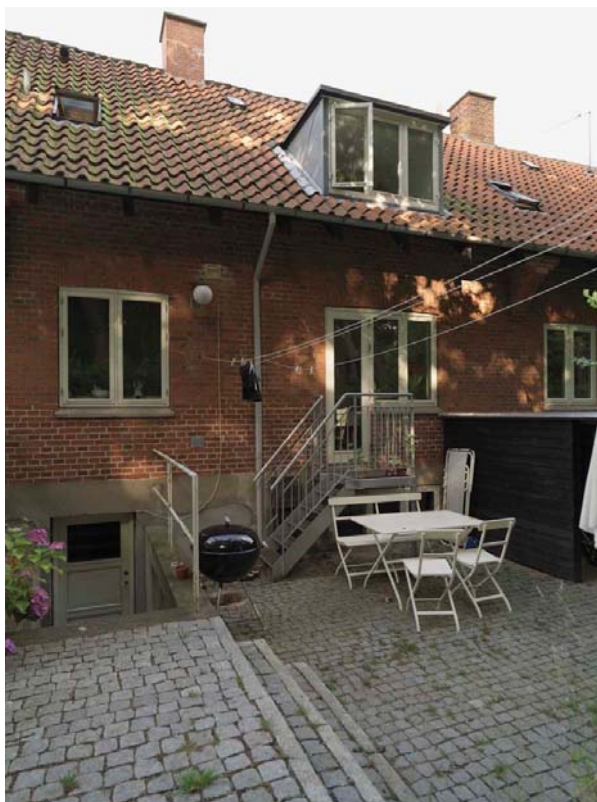
Eksempel på en havedør der er isat, efter huset er opført. Havedørens dimensioner forholder sig til det oprindelige 3-fagsvindue, i overensstemmelse med lokalplanens bestemmelser.
