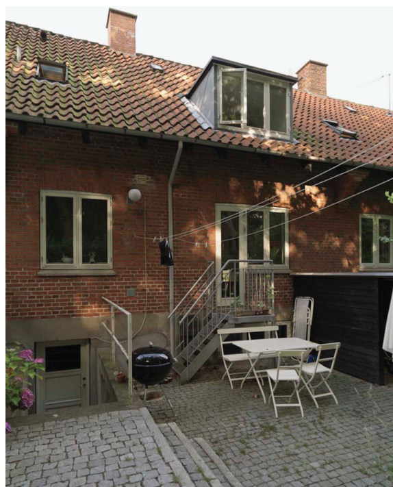
Østfacade, hvor der er isat en havedør
