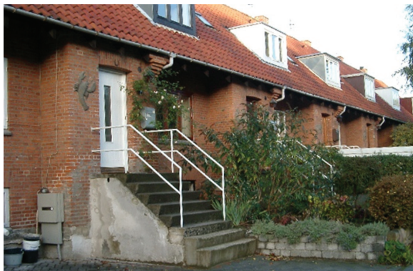
Indgangsfacade med trappe
